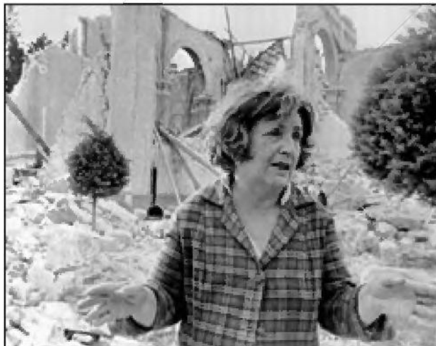
I danni provocati dal terremoto del 1976 in Friuli
